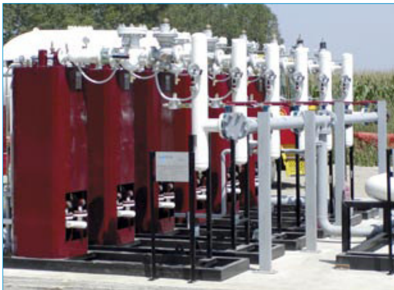
Vaporizing unit 6000 kg/h capacity with 6x1,000 kg/h Samvap WA-O Gruppo di vaporizzazione portata 6000 kg/h con 6x1.000 kg/h Samvap WA-O
